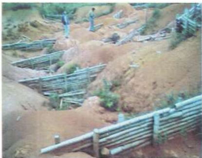
Inadecuado empleo de trinchos muertos como obras de contención. Junio 2004
