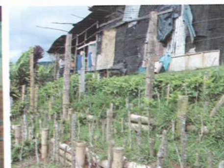
Tratamiento de bioingeniería, Noviembre 2004
