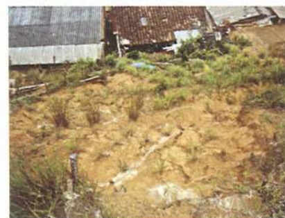
Estado inicial vivienda de Edward Cruz, Septiembre 2005
