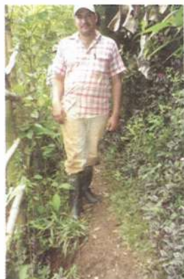
Pérdida de la banca, Servidumbre, Octubre 2005
