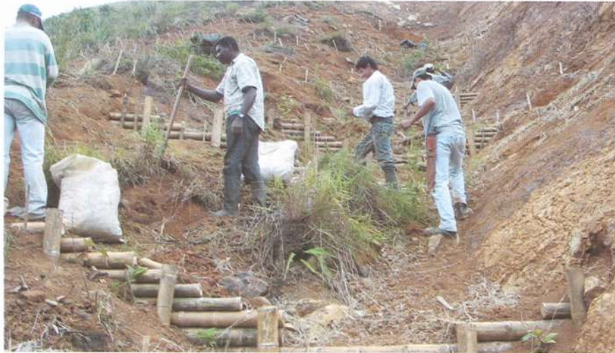
Recuperación de una cárcava remontante con bioingeniería. Vereda La Cajita, cuenca río Cali.
