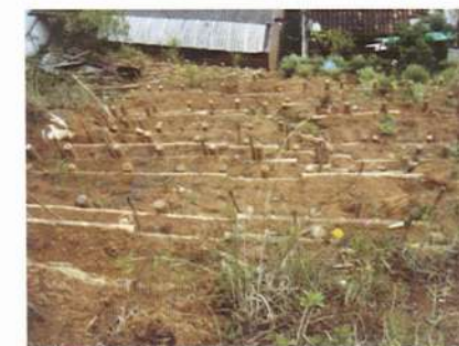
Instalación de tratamientos que integran filtros y terrazas.
