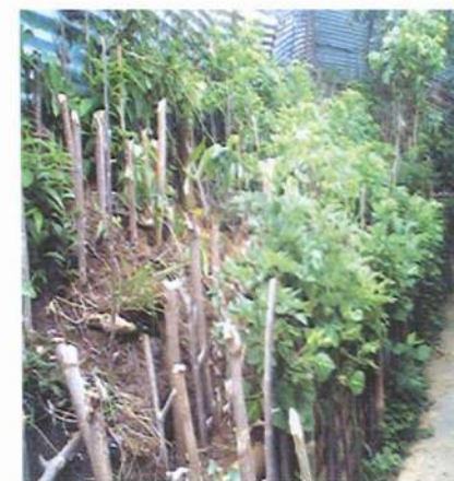
Construcción de terrazas vivas escalonadas, Enero 2004
