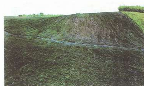
La concentración de flujos de aguas por determinadas rutas conforman pequeños surcos paralelos que al unirse se transforman en cárcavas.
