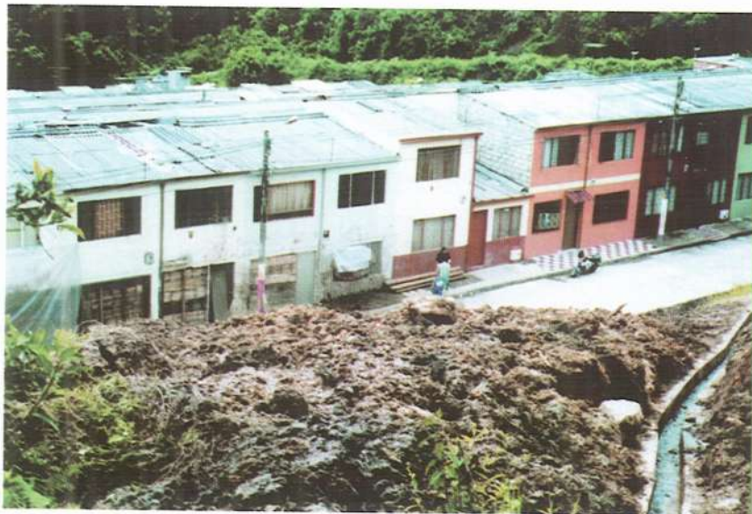
El socavamiento de la base de las laderas, el mal manejo de las aguas y la deforestación son factores comunes que aceleran la aparición de remociones masales.
