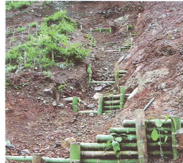
Trinchos vivos escalonados con vertedero construidos con material vegetal con capacidad de rebrotar.
