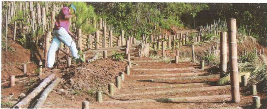
30 Disipadores simples construidos con guadua para reducir la velocidad del agua de escorrentía.
