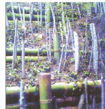
Secuencia de trinchos vivos escalonados para estabilización de un talud
