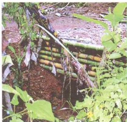
Recuperación de la vía a Villa Rosa.
