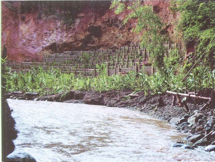
Obras bioingenieriles para la estabilización de taludes ribereños. Río Dagua, Valle del Cauca.
