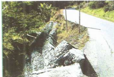
Muro de gaviones derrumbado en poco tiempo sobre una vía asfaltada: altos costos sin solución.
