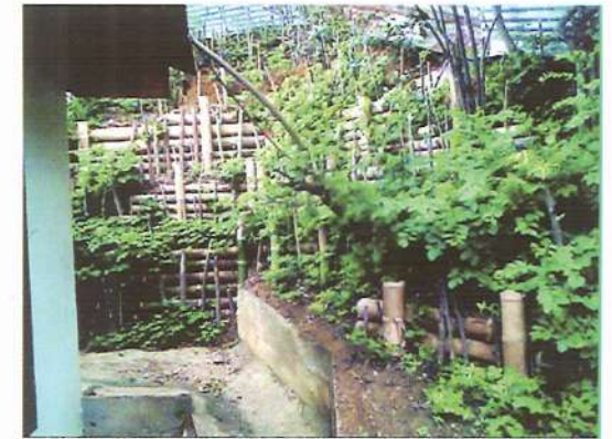
Empleo de estacas vivas con capacidad de rebrote. Sede de la CVC -DAR Pacífico este.
