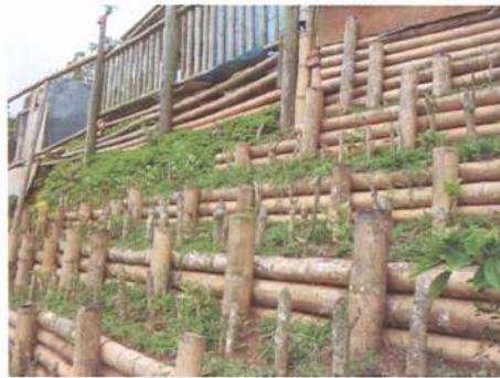
Tratamiento de bioingeniería, Noviembre 2004
