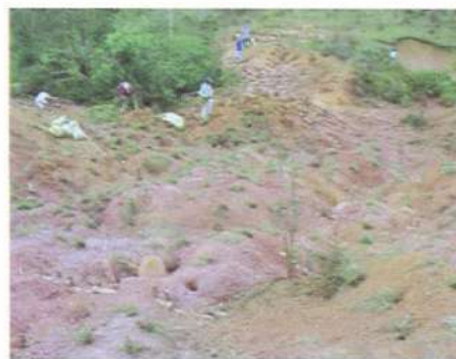
Son sustituidos por trinchos vivos encargados de disipar la velocidad del agua de escorrentía y favorecer la estabilización. Agosto 2004
