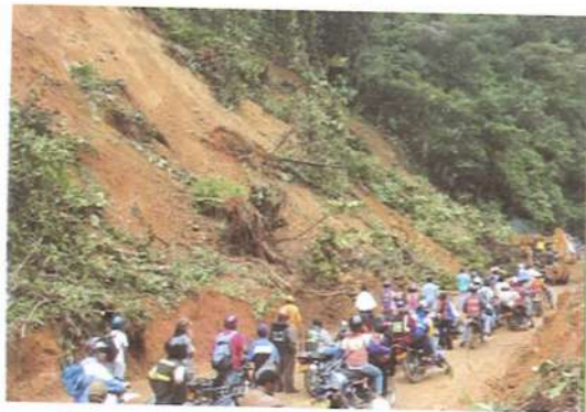
Taponamiento por deslizamiento en el Km 21 vía Buenaventura, mayo 6 de 2006
