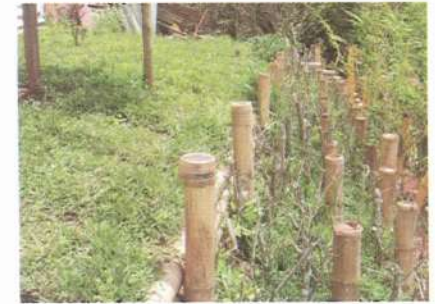
Estabilización con terrazas vivas escalonadas, Mayo 2004
