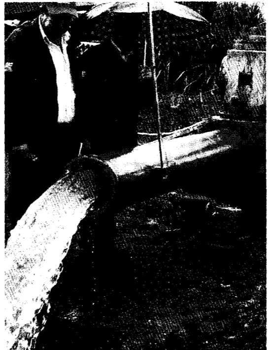
Foto 8. Supervisión construcción de pozos. Prueba de bombeo pozo Vp-792 Hda. Josepilla, municipio de Palmira.
