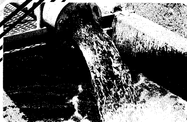
Descarga de Aguas Subterráneas Pozo Vp286- Manuelita- Palmira
