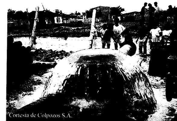
Foto 4. Pozo con flujo saltante que aprovecha el nivel inferior del acuífero. Distrito de Aguablanca. Cali.
