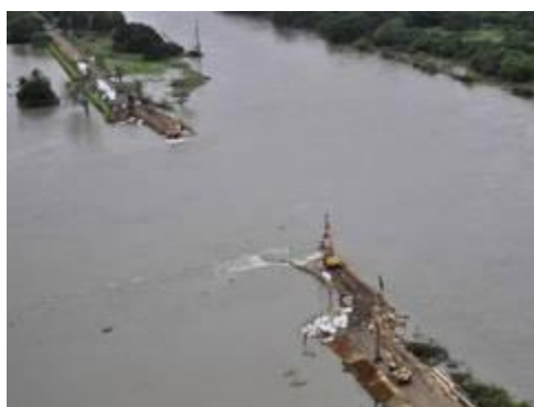
Figura 1.25. Rotura del canal del Dique. Año 2010
