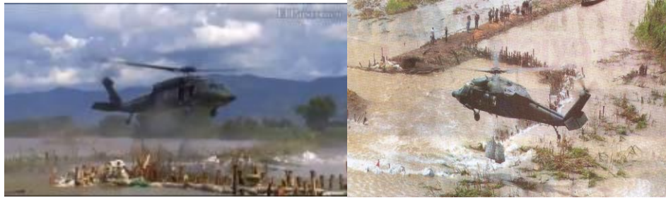
Figura 1.38. Taponamiento de las roturas en los diques por las fuerzas armadas de Colombia
