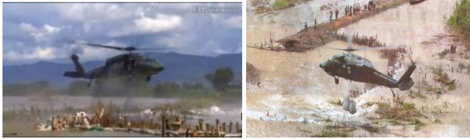
Figura 1.38. Taponamiento de las roturas en los diques por las fuerzas armadas de Colombia
