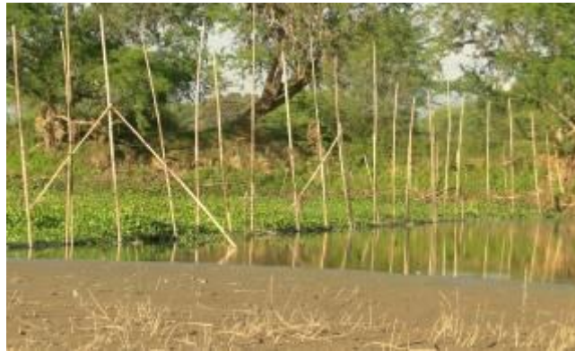
Figura 2.28. Barrera de guadua realizada para evitar el paso de macrófitas al espejo de agua libre.
