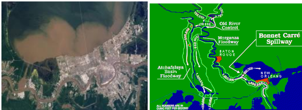
Figura 1.41. Apertura de vertederos realizada por el Cuerpo de Ingenieros de los Estados Unidos para proteger las ciudades Fuente. US Army Corp of Engineers. 2011
