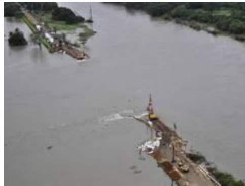
Figura 1.25. Rotura del canal del Dique. Año 2010
