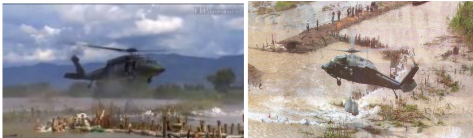
Figura 1.35. Taponamiento de las roturas en los diques por las fuerzas armadas de Colombia Fuente. Periódico El País, Colombia
