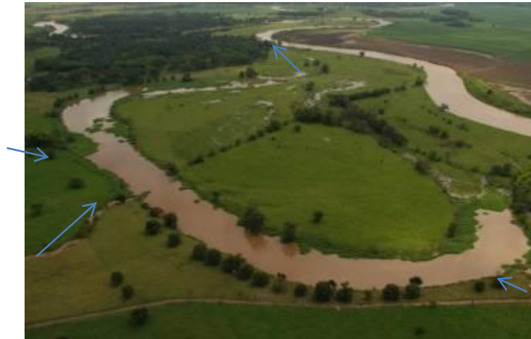
Figura 3.23. Ingresos de aguas de escorrentía provenientes de drenajes naturales
