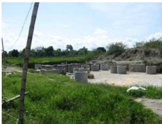
Figura 2.94. Foto de la PTAR en construcción
