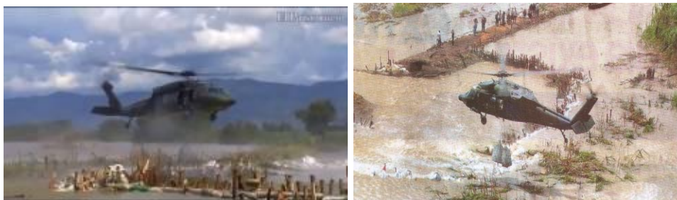
Figura 1.35. Taponamiento de las roturas en los diques por las fuerzas armadas de Colombia Fuente. Periódico El País, Colombia
