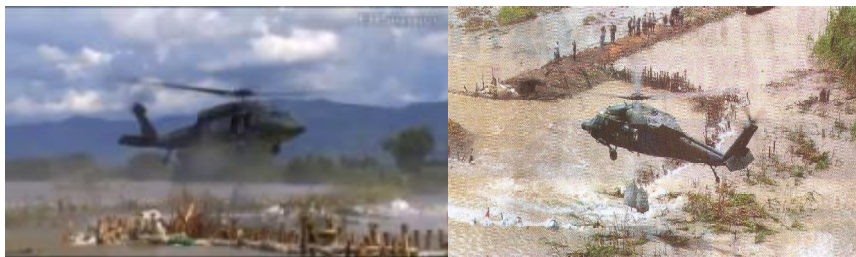
Figura 1.39. Taponamiento de las roturas en los diques por las fuerzas armadas de Colombia
