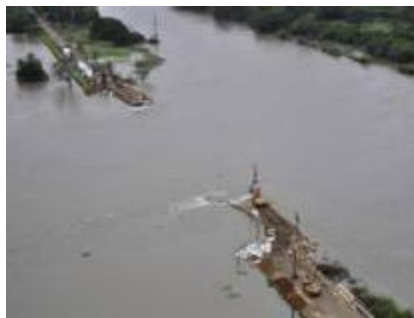
Figura 1.26. Rotura del canal del Dique. Año 2010
