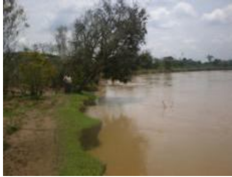
Figura 2.27. Volcamiento de barrancos y caída de árboles por socavación lateral en el río Cauca aguas arriba de la madreveja El Avispal
