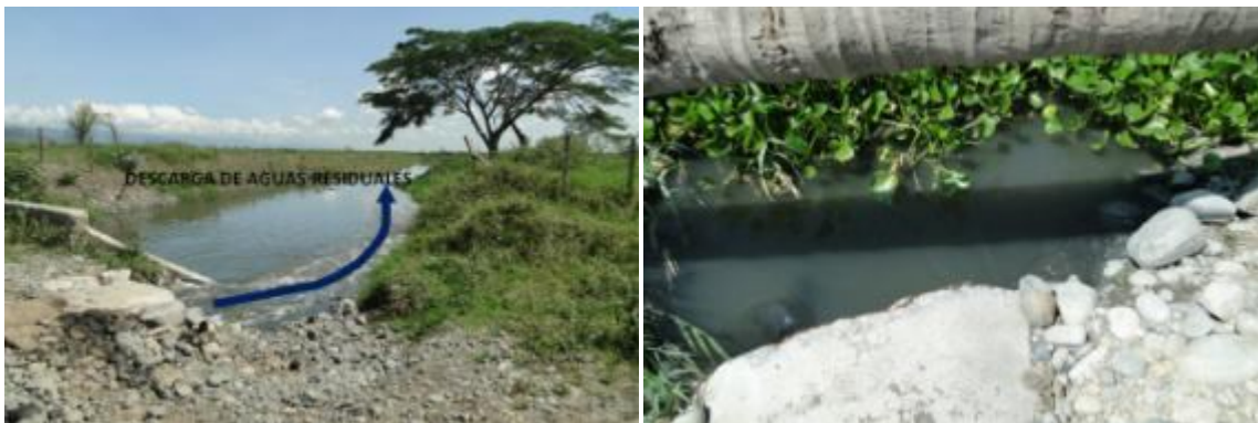
Figura 3.28. Llegada de aguas residuales a la laguna
