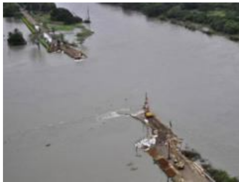
Figura 1.25. Rotura del canal del Dique. Año 2010 Fuente. URL-3
