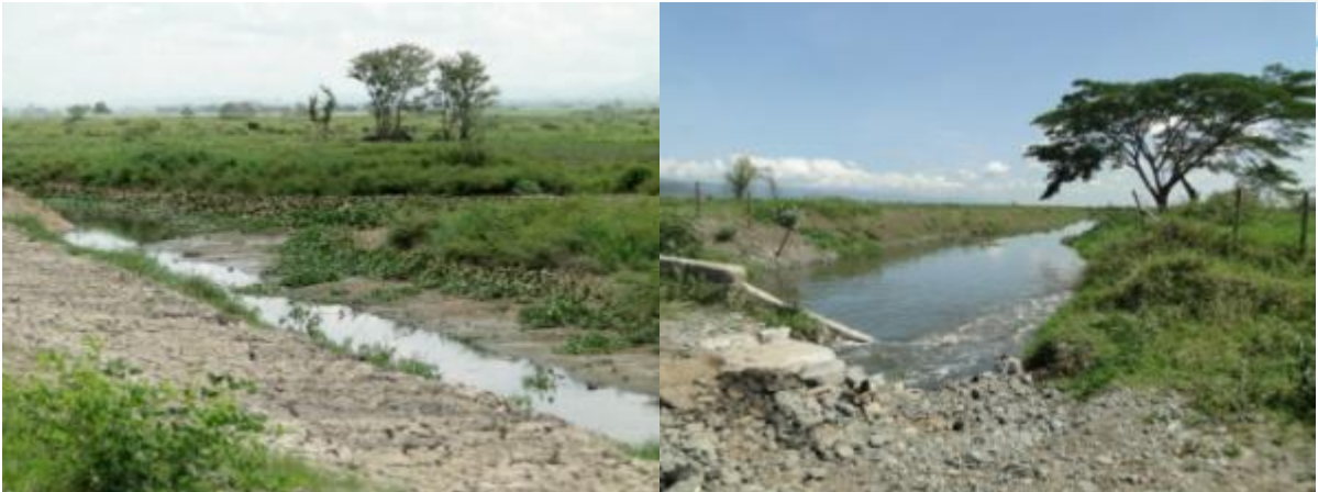
Figura 2.4. Entrada de las aguas negras, a través del canal que bordea parte del humedal
