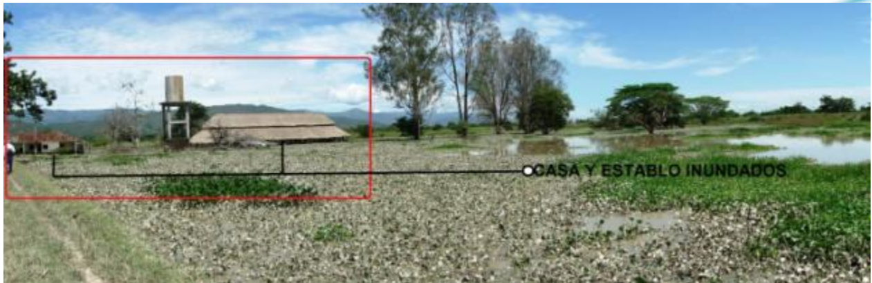
Figura 3.26. Casa y establo abandonados por inundación
