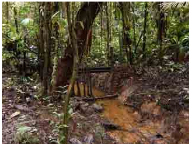
Foto 33: Trincho utilizado para la detención del agua de la quebrada.
