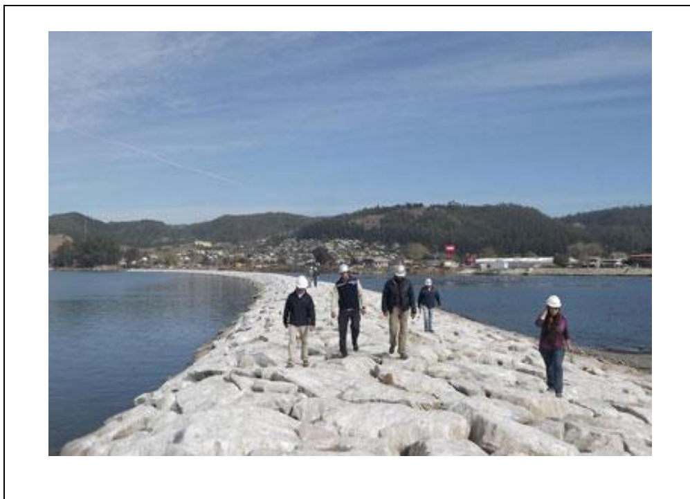
Fotografía 3. Dique en enrocado (vista b)
