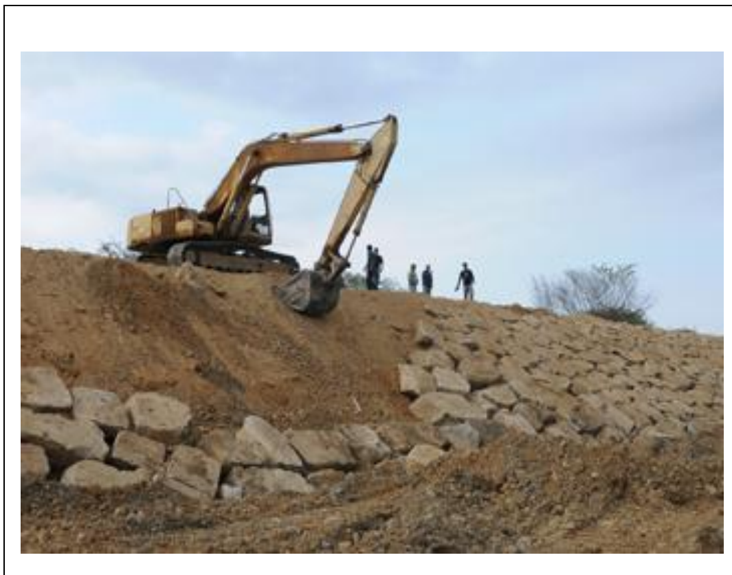
Fotografía 4. Uso de enrocado para protección de taludes (rip-rap)
