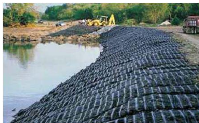
Fotografía 7. Protección del talud con geocolchón
