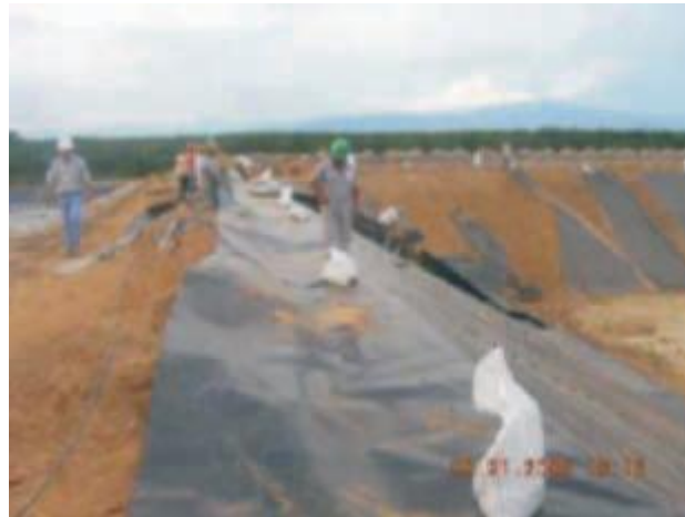
Fotografía 41. Instalación de geomembrana sobre el talud mojado de un terraplén
