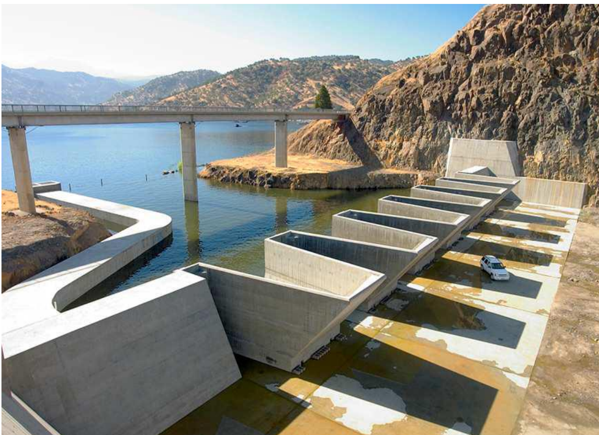
Fotografía 21. Compuertas fusible en la Presa Terminus – California, Estados Unidos
