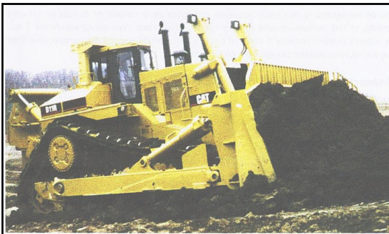
Fotografía 36. Bulldozer en etapa de extendido del material para luego ser compactado
