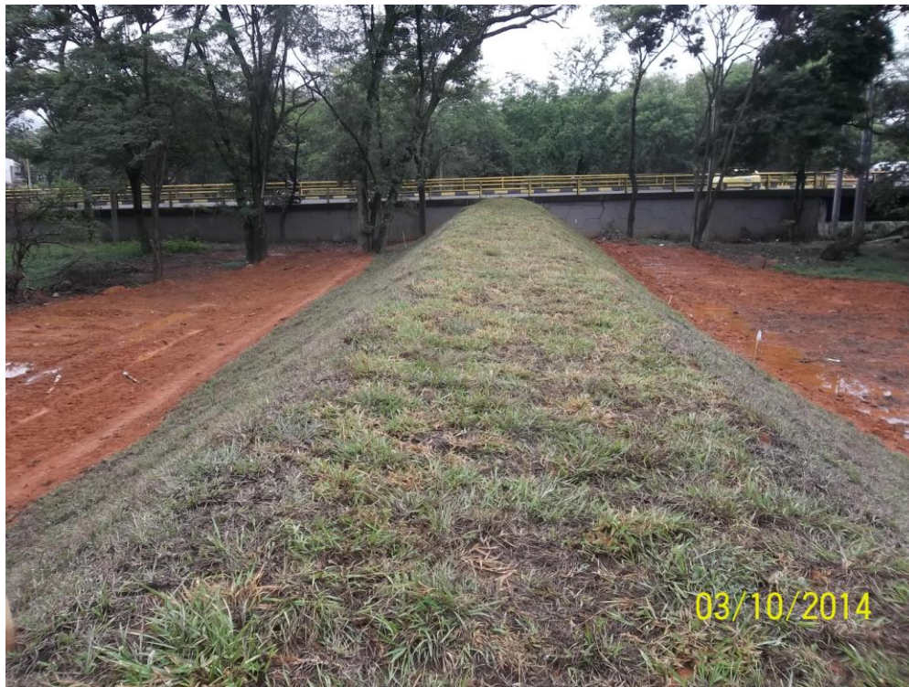
Engramado del nuevo dique, que entre febrero y marzo del año 2014, está construyendo la CVC sobre la margen derecha del río Meléndez en la zona del separador de la autopista Simón Bolívar de Cali.
