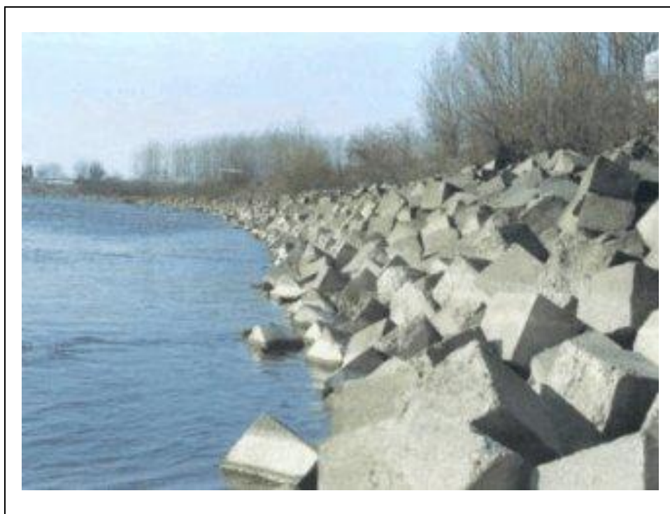
Fotografía 12. Protección de orilla con poliedros
