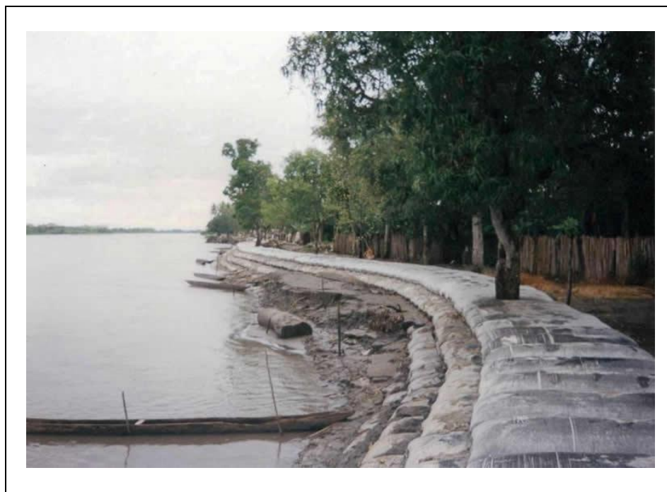
Fotografía 5. Dique en bolsacretos y geocolchón
