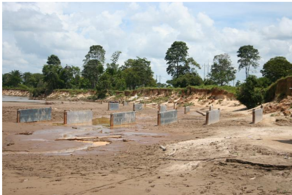
Fotografía 13. “Cauce del río Banadía en el Sector S3, ubicado aguas abajo del terraplén de la carretera, pocos días después de la instalación de los conjuntos de paneles en este sector. (HIDROCONSULTA LTDA., octubre, 2006)”.
