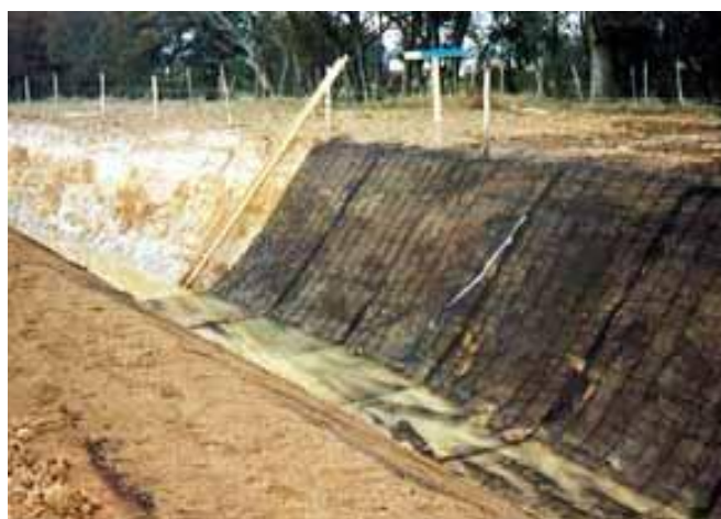
Fotografía 18. Canal de tierras protegido con geomantas
