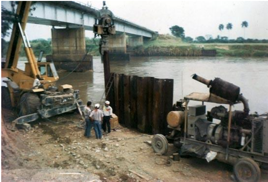
Fotografía 35. Trabajos de hincado de una tablestaca metálica.
