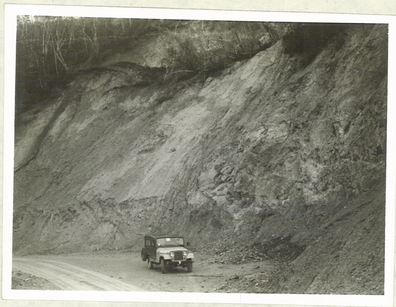
Fotografía No. 15 Zona de inestabilidad carretera Pueblo Nuevo-Caldono K. 9 + 950.
