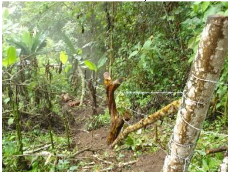
Ilustración No 20 Avance Cercas Vivas y tres líneas de alambre
