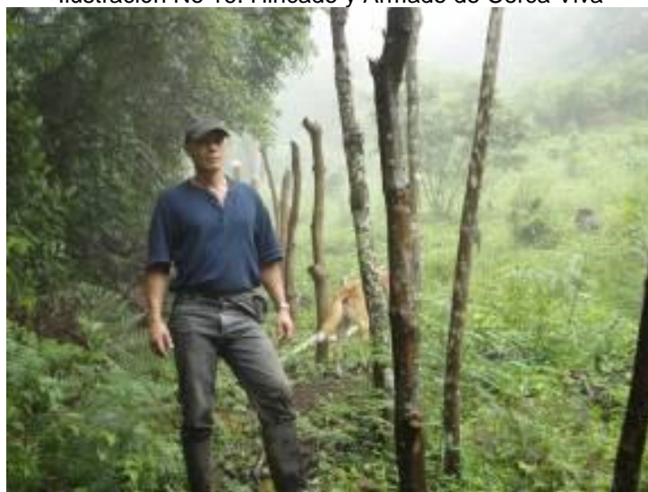
Ilustración No 16. Hincado y Armado de Cerca Viva
