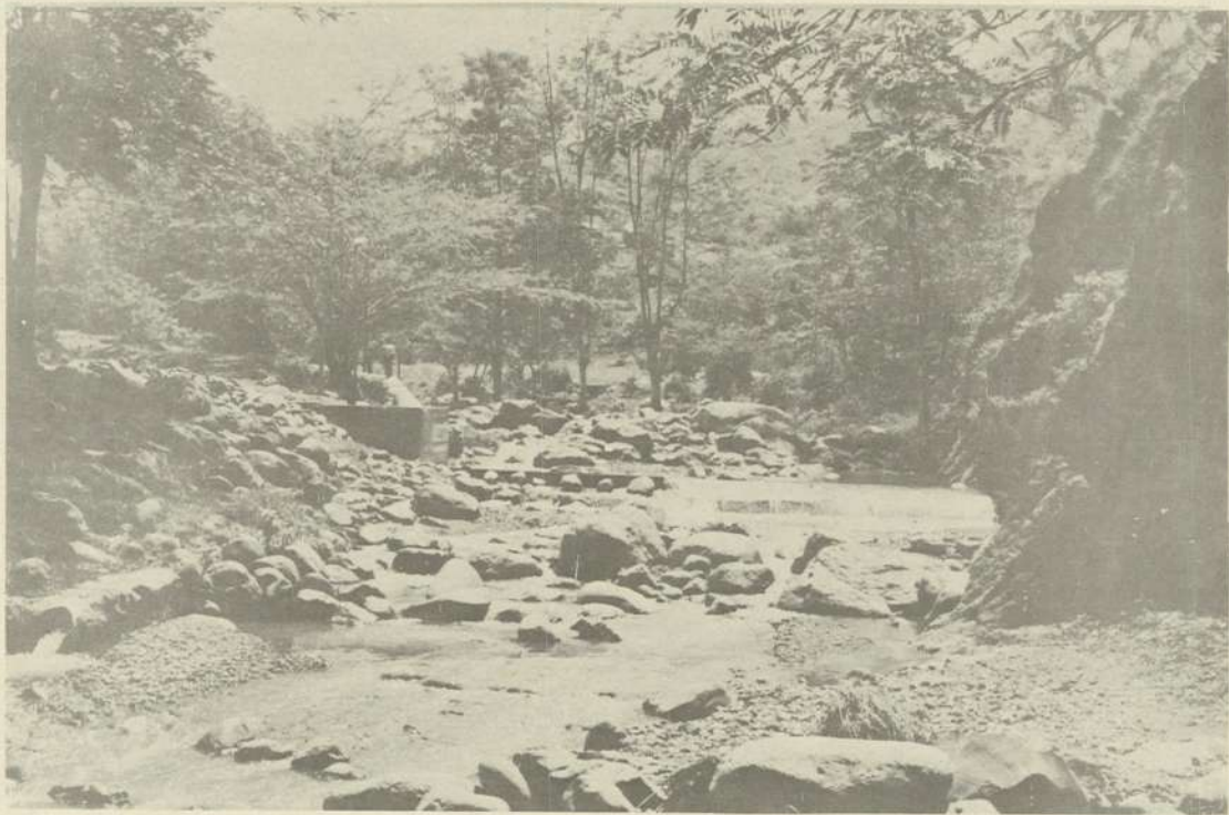
FOTOGRAFIA N° 6 Bocatoma para el acueducto sobre el Río Yumbo.
