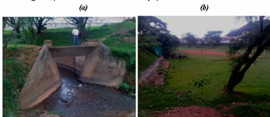
Gráfico 160. Estructura de control (vertedero) para almacenamiento y laminación del pico de crecientes y (b) Zona de embalse utilizada para actividades de recreación.
