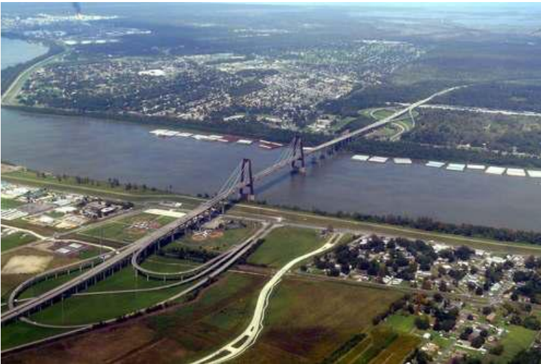
Fotografía 4. Puente Hale Boggs en Louisiana – Río Mississippi. Fuente: Google earth. 2015.
