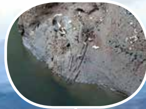
Marcas de arañazos en los barrancos
