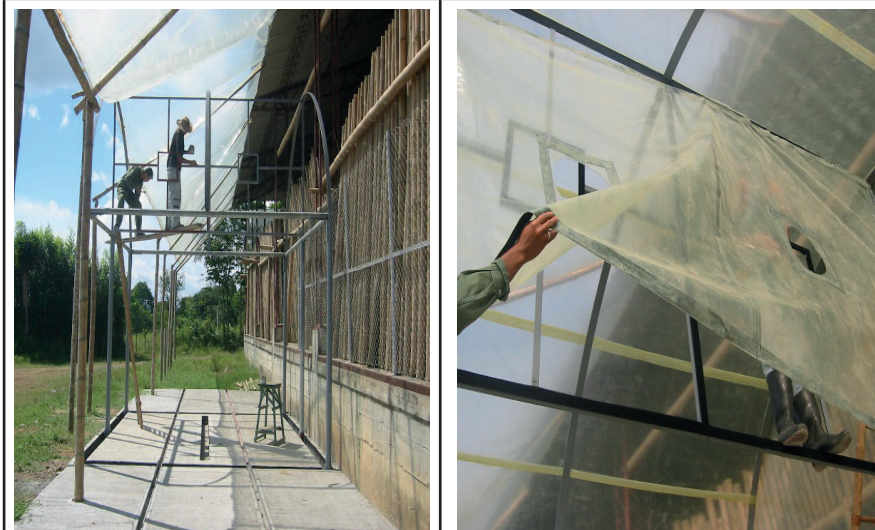
Construcción estructura del secador solar, Guadua rolliza
