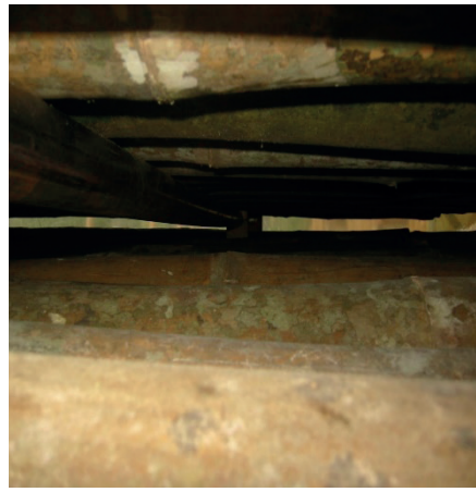
Detalle de apilado de la Guadua e instalación de elementos separadores
