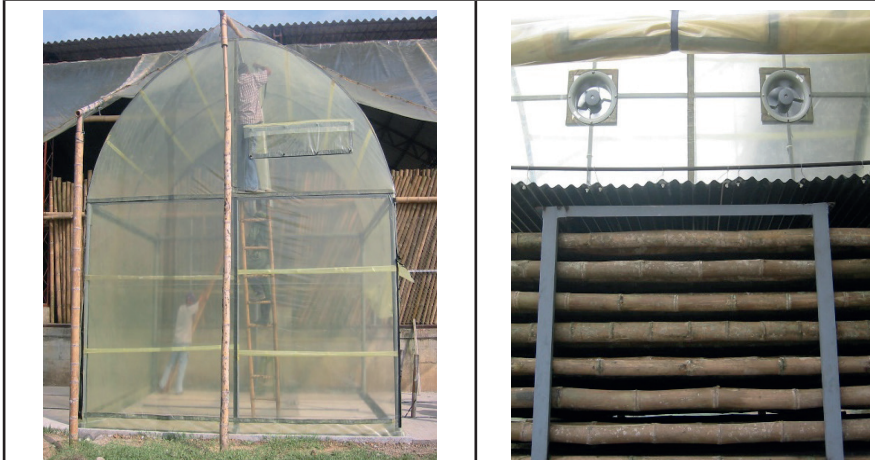
Instalación de plástico en secador solar, Guadua rolliza
