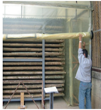
Proceso de secado, Guadua rolliza
