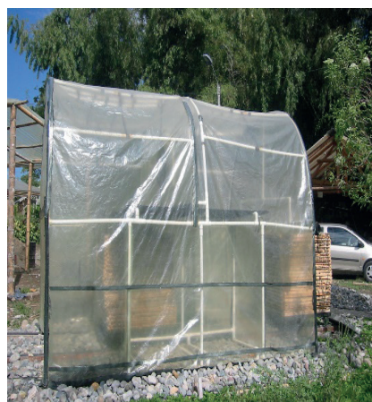
Estructura en PVC y plástico UV calibre 6.
