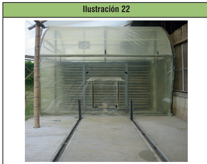
Ilustración 22: Secador solar tipo invernadero Guadua rolliza, ventilación Transversal, doble ventilación, vista lateral, DANSA INT.
