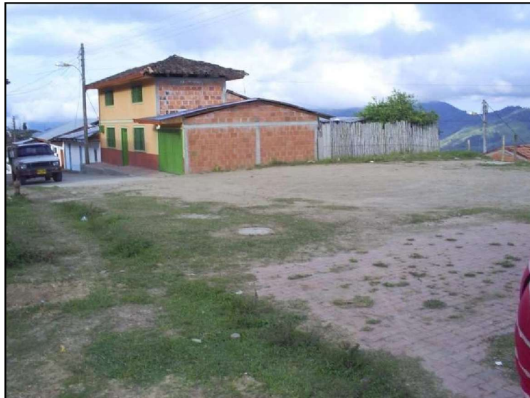
Foto 7.9 Zona de expansión municipio de El Cairo; sector la casa atravesada.
