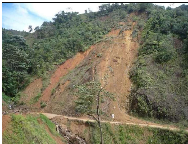
Foto 7.6 Deslizamiento en la carretera Las Brisas.
