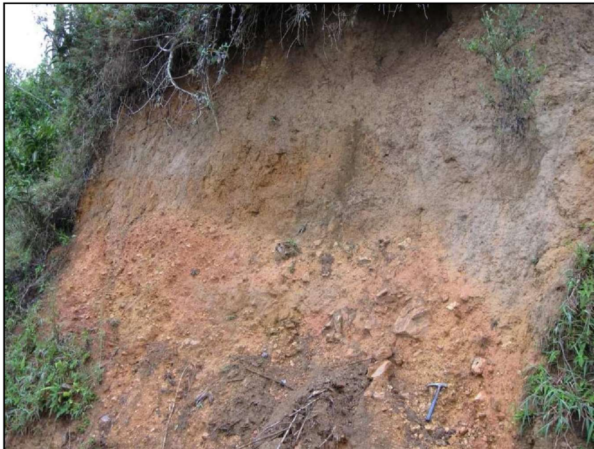
Foto 5.3 Roca fracturada y suelo de tipo arcilloso.
