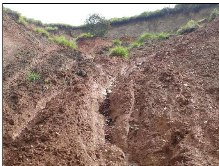
Foto 7.7 Deslizamiento activado por la escorrentía superficial sobre la carretera Las Brisas.
