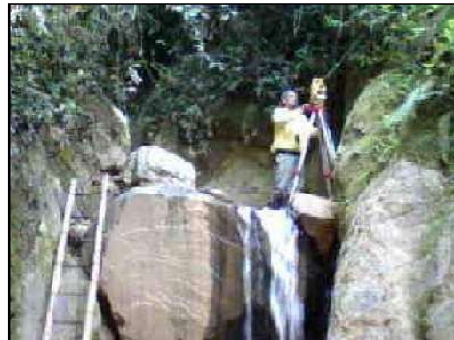
Foto 3.2 En algunos casos fue necesario utilizar Escaleras y otros accesorios para superar las dificultades del terreno.
