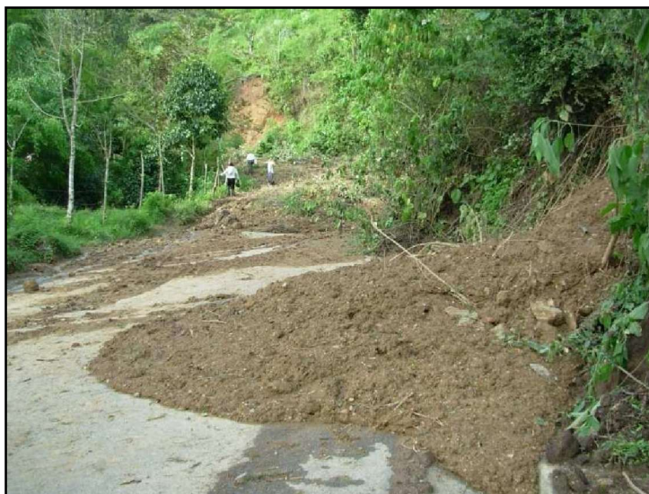
Foto 2.3 Derrumbe en la vía principal. Invierno de noviembre y diciembre de 2008. Fuente: Corposerraniagua
