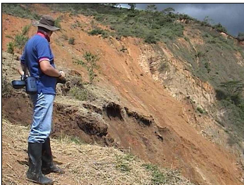
Foto 2.1 Observación reactivación de la Cárcava de Tejares -12 de diciembre de 2003. Fuente: Corposerraniagua.
