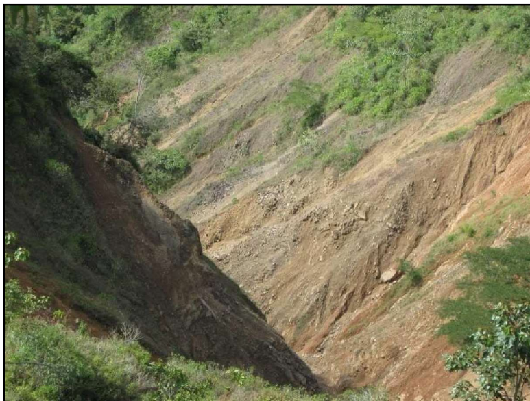
Foto 5.11 Vista de los escarpes que muestran la zona más afectada de la cárcava.
