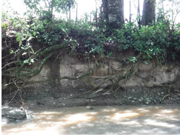
Figura 3.53. a. (T035): Exposición de raíces de árboles producto de erosión de la quebrada Toro. b. (T039): Erosión continúa del talud; los habitantes de la casa coloquen rocas tamaño bloques para disminuir la erosión.
