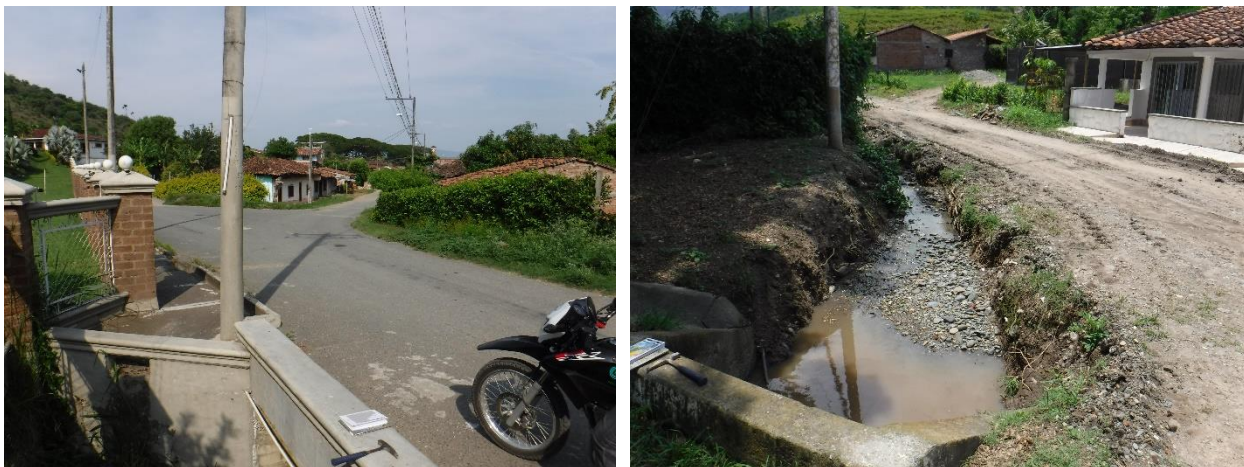
Figura 3.62. Estaciones T002 y T078, zona afectada por inundaciones
