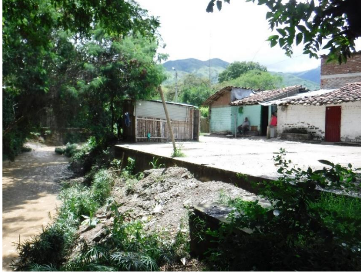
Figura 3.65. Área afectada por inundaciones, nótese que el tanque en cemento y las casas están al borde de la Qb. Lázaro sin ningún área de protección de la quebrada.
