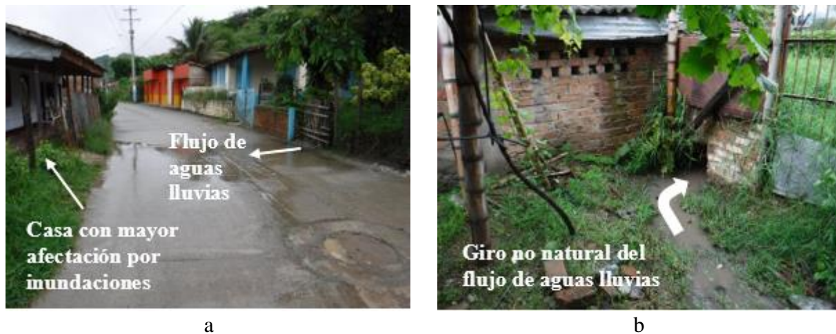
Figura 3.60. a. (T049): Carrera 6 #15-109, se aprecia aguas lluvias bajar por la ladera del cerro, pasar por la puerta del patio de la casa y afectar la casa del frente, ya que dicha casa está a un nivel más debajo de la vía. b. (T051): Se aprecia quebrada intermitente que hace un giro no natural de 90° a la derecha por la construcción de una casa.
