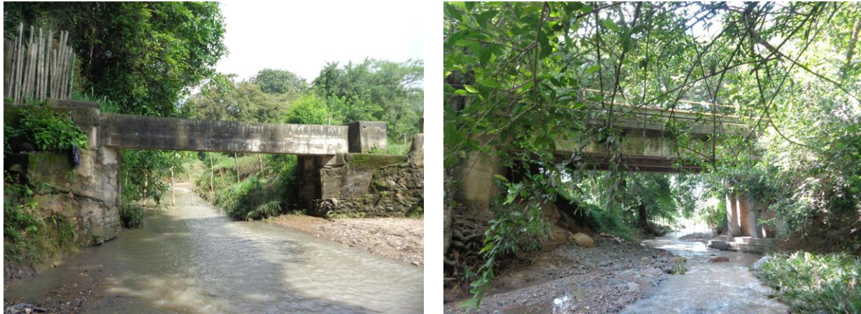
Figura 5.3. Estructuras sobre la quebrada De Lázaro en el municipio de Toro
