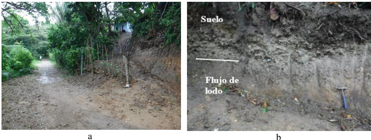
Figura 3.64. Estación T031: a. se aprecia la casa en la dirección carrera 1 #600 a unos 6 m de alto de la Qb. Toro. b. muestra pequeño afloramiento con la capa superior de suelo y debajo de ella el flujo de lodo.
