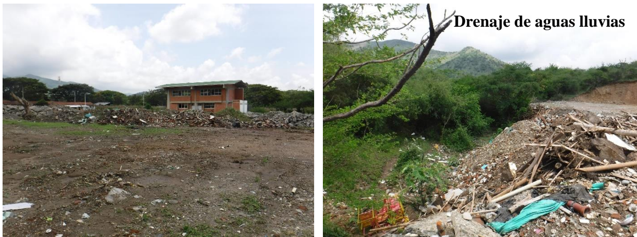
Figura 3.51. (T072 y T073): Parte SW o detrás de la escuela nueva, se aprecia como se llena el lugar y el drenaje natural de aguas lluvias de escombros (Suelo antrópico mixto – Sa).
