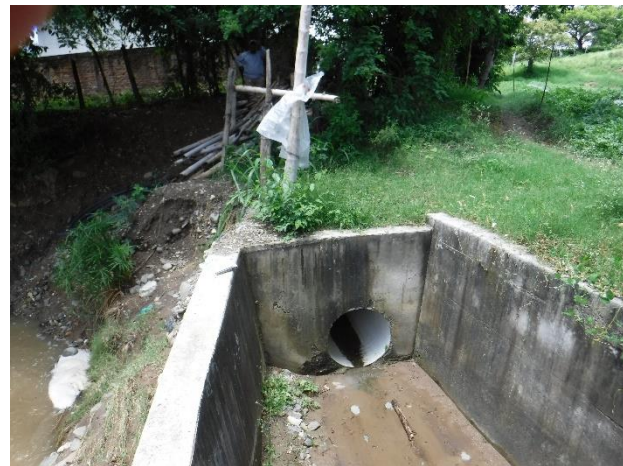
Figura 3.54. (T044): Obra civil que obliga a la quebrada Toro hacer un giro brusco a su derecha provocando erosión
