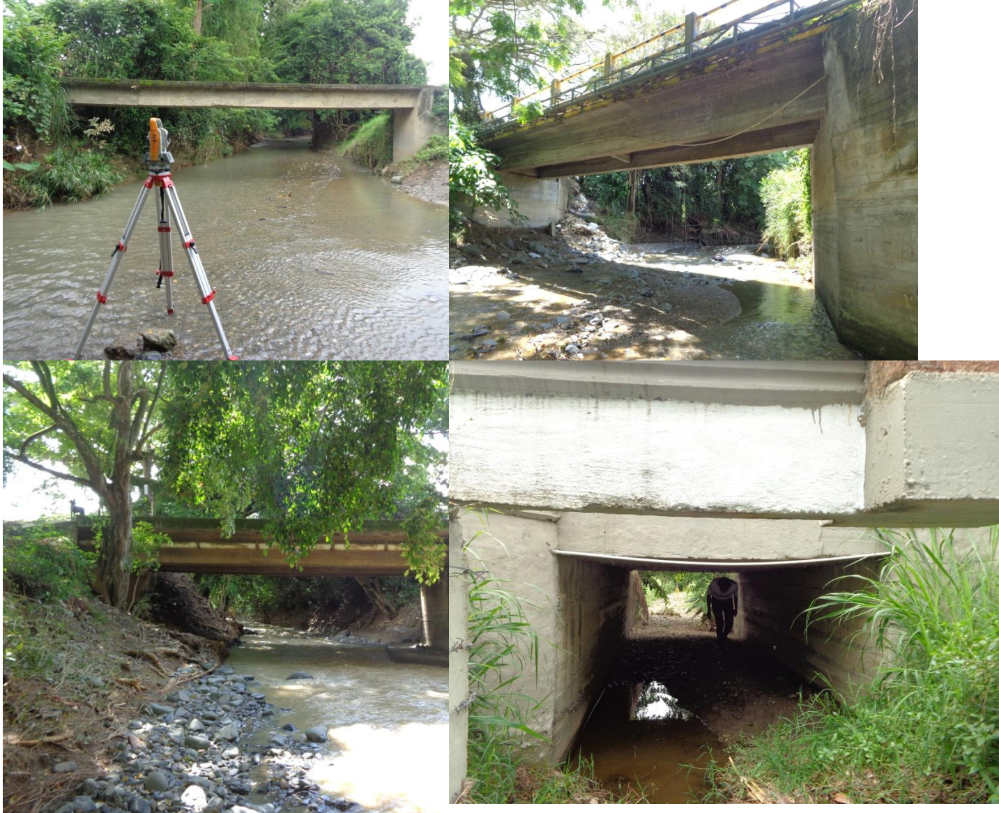
Figura 5.2. Obras hidráulicas ubicadas sobre la quebrada Toro Fuente: fotografía propia
