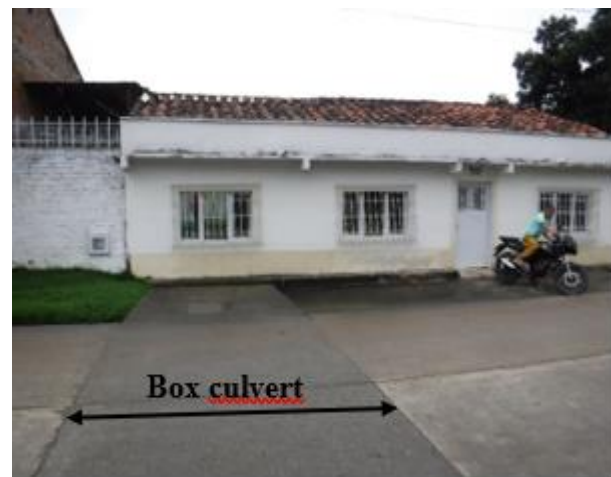
Figura 3.56. a. (T011): Carrera 6 con calle 10. Box culvert de 2,3 m X 0,70 m de alto al cual le construyeron una casa encima. b. (T017): Calle 12 # 5-35 y #5-45, se aprecian viviendas encima del box culvert, situación común en diferentes puntos del recorrido de la canalización.
