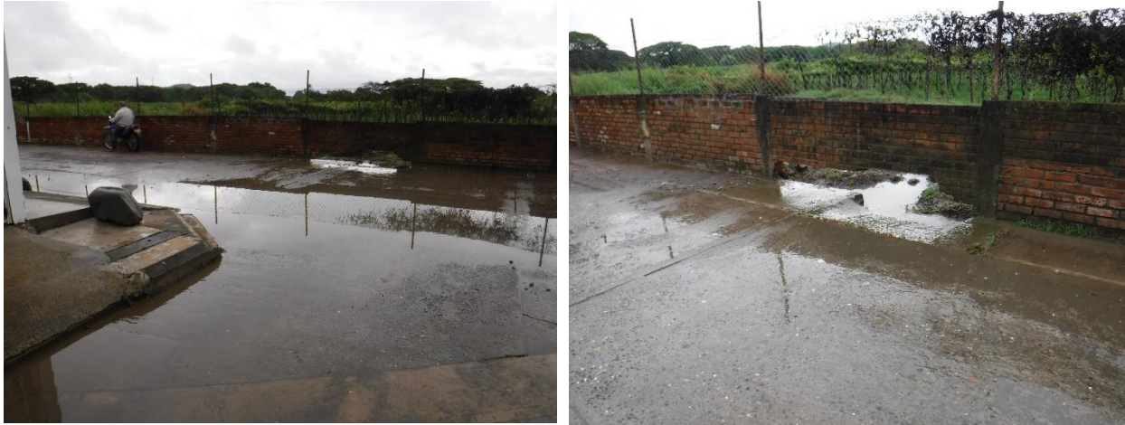
Figura 3.61. (T047): Fotos ubicadas en la calle 18 con carrera 3, uno de los sitios afectados por inundaciones de agua lluvia, nótese como los habitantes del sector rompieron el muro en la parte de abajo para que el agua no se empoce.
