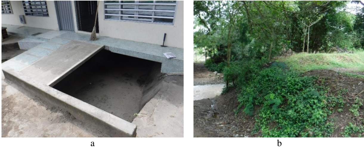
Figura 3.37. a. (T011): Box culvert con construcción de casa encima de él, lo cual aumenta el riesgo de inundación y afectación de las viviendas. b. (T039): Dique antrópico a margen izquierda de la Qb. Toro para prevención de inundaciones, pero dicho dique fue cortado para hacer una vía de acceso a una finca al otro lado de la Qb.
