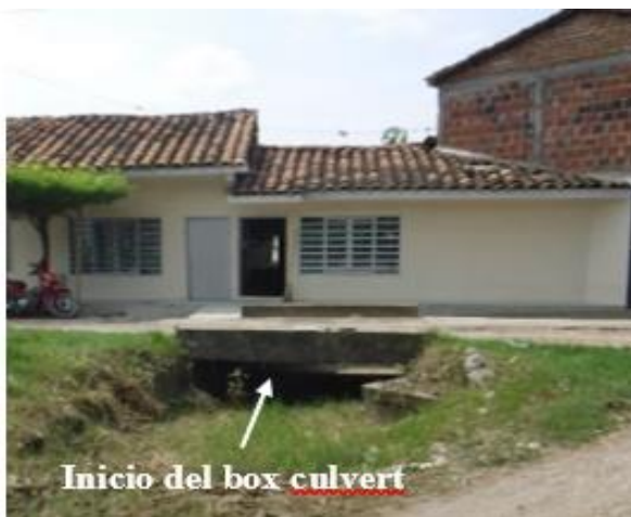
Figura 3.56. a. (T011): Carrera 6 con calle 10. Box culvert de 2,3 m X 0,70 m de alto al cual le construyeron una casa encima. b. (T017): Calle 12 # 5-35 y #5-45, se aprecian viviendas encima del box culvert, situación común en diferentes puntos del recorrido de la canalización.
