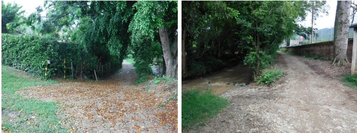
Figura 3.63. Estaciones T032 y T033 respectivamente: Márgenes de la Qb, Toro las cuales presentan construcciones a 4 m, estas vías se han visto afectadas por inundaciones de la Qb Toro en varias ocasiones, es de anotar que las vías están entre 1,5 y 2 m de alto del nivel de la quebrada.
