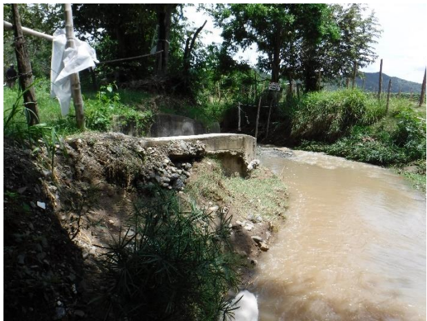
Figura 3.54. (T044): Obra civil que obliga a la quebrada Toro hacer un giro brusco a su derecha provocando erosión
