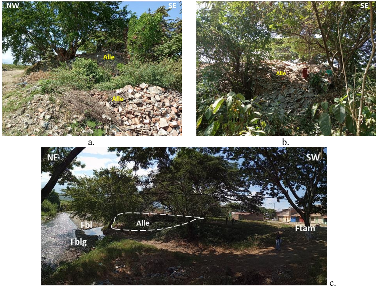
Figura 3.23. a. Llenos antrópicos mixtos que reemplazan el material de la terraza aluvial baja (Ftab) del río Bolo, en los alrededores de la Cra 13. b. Detalle del lleno mixto con profundidad aproximada de 2m. c. Geoformas en el sector del barrio Primero de Mayo, alrededores de la Cra 14.
