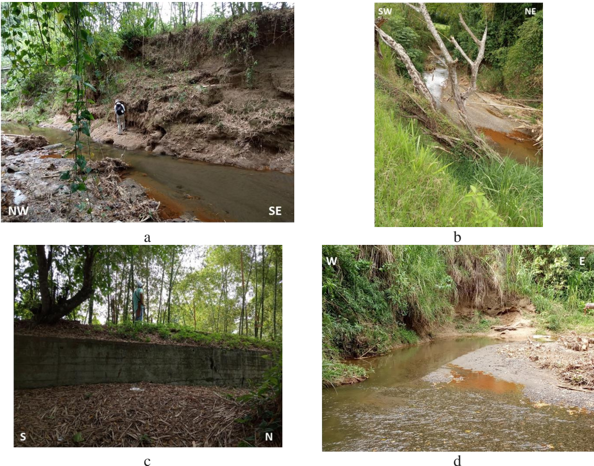
Figura 3.76. a. Erosión en la ladera derecha de la quebrada, estación O48. b. Curva erosiva (estación O49). c. Zona erosiva protegida con muro de contención (entre estaciones O53 y O54). d. Curva erosiva en la estación O54.
