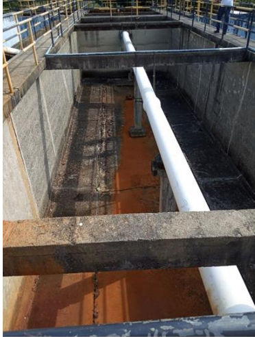
Tanques con fisuras que fueron inhabilitados
