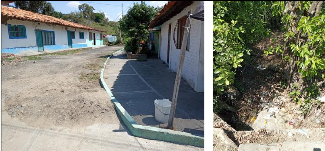
Figura 3.80. Canal del barrio Las Brisas y su salida del Box Colvert, donde continua como un canal sin recubrimiento.
