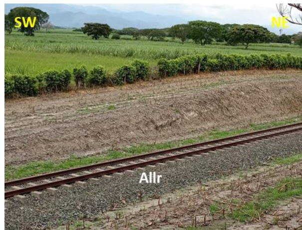
Figura 3.55. a. Lleno de roca (Allr), línea férrea.
