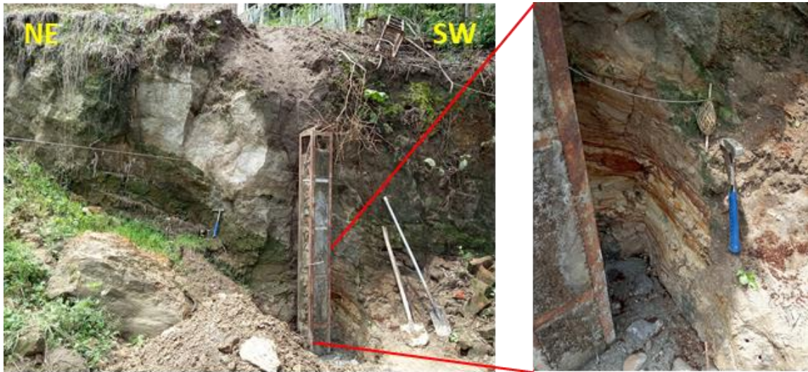
Figura 3.13. Estación O85, atrás de la Escuela Ricardo Nieto afloran secuencias de areniscas finas separadas por hiatos de hasta 1cm de espesor, suprayacidas por secuencias de tobas grises y areniscas finas de color amarillo ocre.
