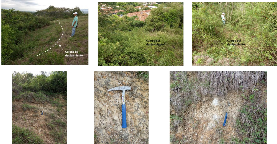
Figura 3.71. Deslizamiento del Barrio San Rafael, corona, cuerpo de deslizamiento y litología. Fuente: fotografías propias.
