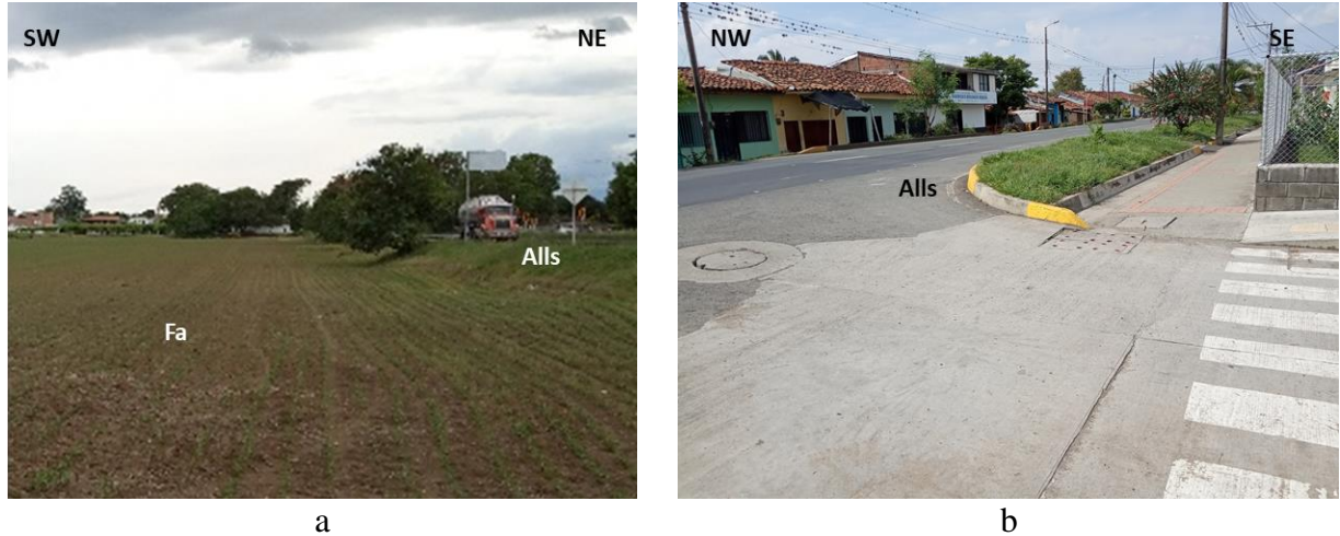
Figura 3.56. a. y b. Evidencia de relleno seleccionado (Alls) en la vía Panorama
