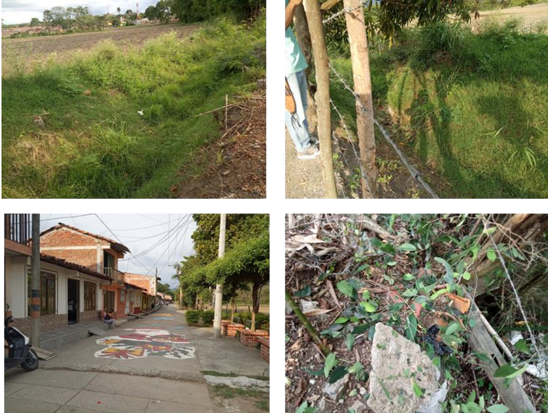
Figura 3.83. Paso del Canal por el barrio Bello Horizonte y su entrada por tubería por debajo del jarillón.
