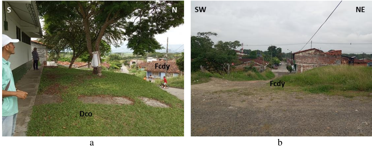
Figura 3.47. Cono de deyección (Fcdy) en el barrio el Prado. b. Cono de deyección (Fcdy) sobre el que se construyó el barrio Santa Bárbara. Fuente: fotografías propias
