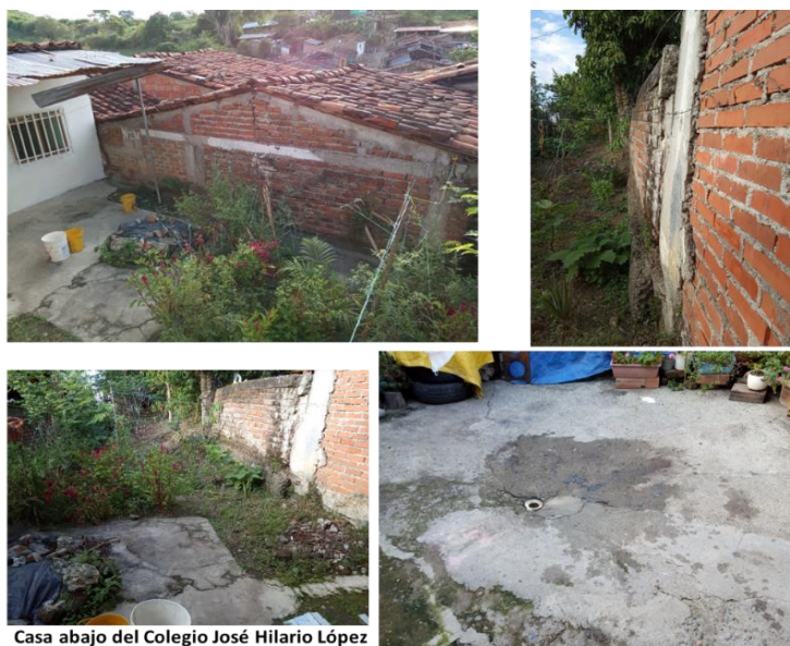
Figura 3.65. Afectaciones en vivienda que soporta el peso de la infraestructura del colegio José Ilario López.
