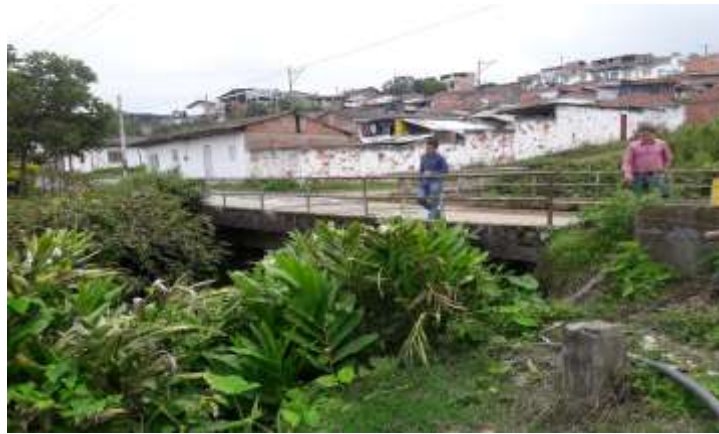
Figura 2.3. Puente Ubicado en la Calle 13, Quebrada Fundadores
