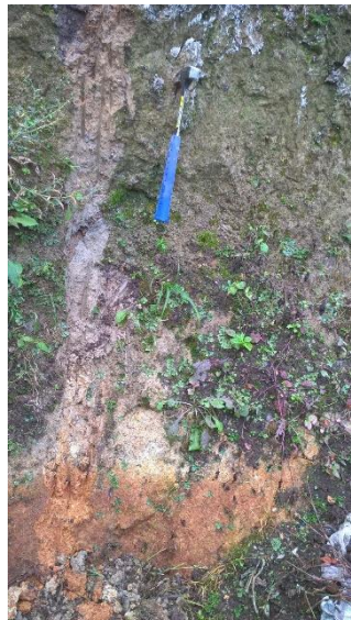
Figura 59. Litología en la corona del hundimiento, quebrada Fundadores. Vista Este-Oeste.
