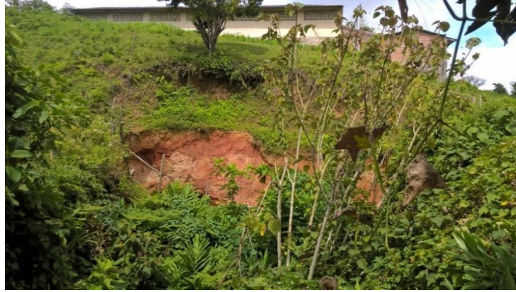
Figura 61. a. Vista E-W de saprolito expuesto por socavamiento ocasionado por la rotura de tubería de aguas negras al Norte del puente de la calle 13, sobre la quebrada Fundadores. b. Vista lateral del socavamiento
