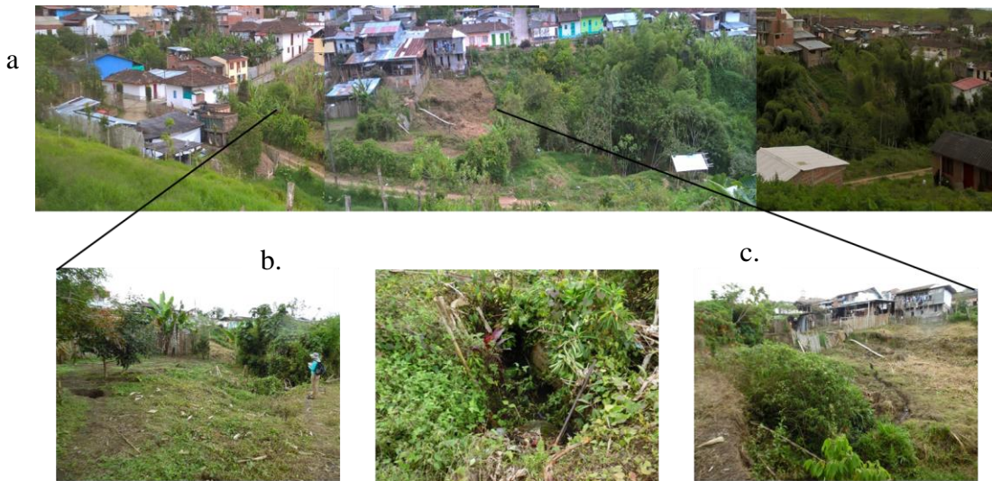
Figura 58. Hundimiento Barrio Guayabito sobre quebrada Fundadores. (a) Panorámica del hundimiento. (b) Evidencias de la progradación del hundimiento hacia el sur; (c) Hundimiento principal a la altura del depósito de madera.
