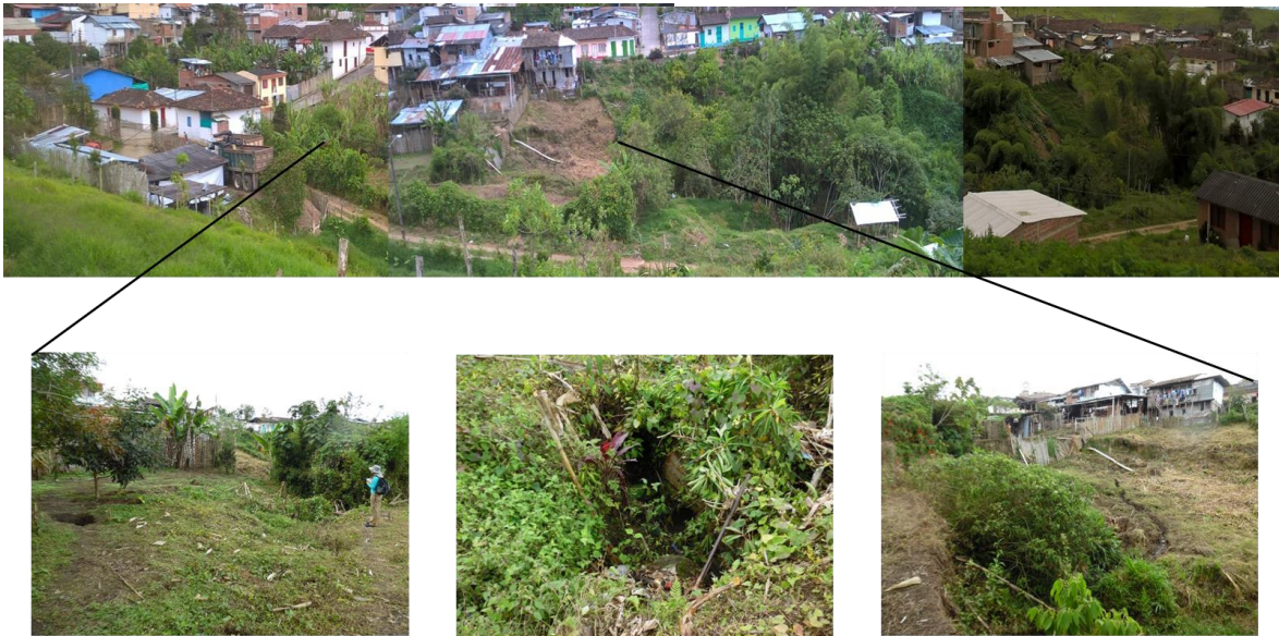
Figura 36. Quebrada Fundadores, su cuenca fue intervenida con relleno mixto (All) y fue urbanizada. Vista Sur-Norte.
