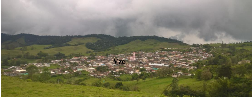
Figura 43. La cabecera municipal de Versalles se encuentra sobre depósitos de ceniza (Vzc).
