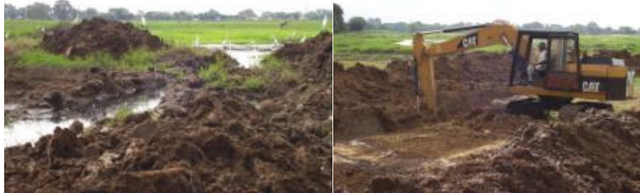
Figura 3.7. Fotografías obras de desecación y drenaje, construcción de jarillón en el predio La Palomera – Buga. 2008
