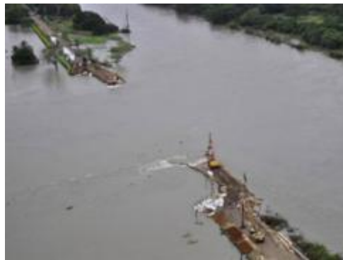
Figura 1.25. Rotura del canal del Dique. Año 2010
