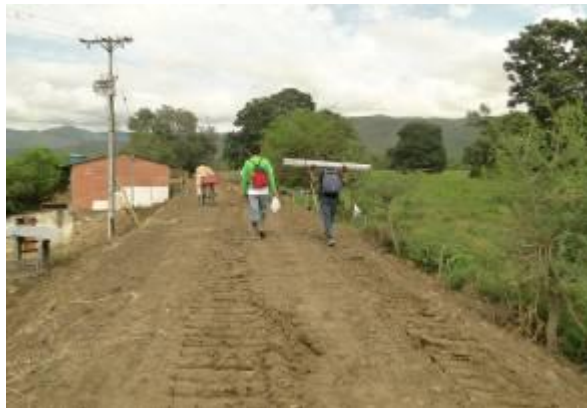
Figura 3.28. Dique-Vía de acceso humedal La Trozada Fuente: María Juliana Bedoya Durán, 2011
