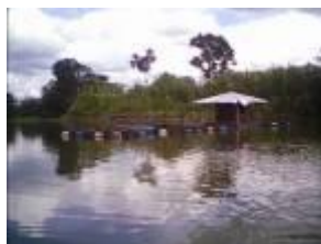
Figura 6.20. Infraestructura para ceba de peces. Bodega flotante y jaulas Fuente: Asogorrones; humedal Madrigal
