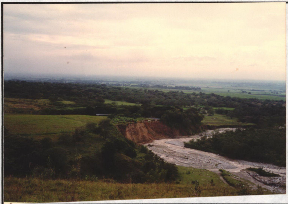
Fotografía 8.17. Zona de socavación del río Fraile. Obsérvese las 2 viviendas ubicadas en la corona del escarpe, a punto de ser alcanzadas.
