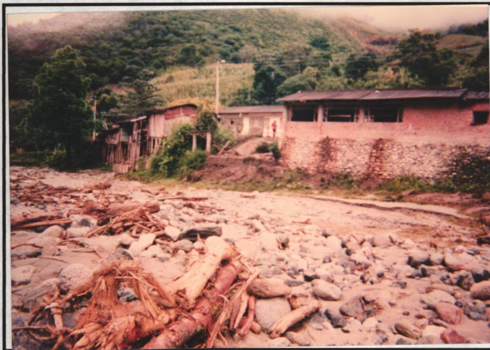
Fotografía 8.6. Contrastes en la constitución de las viviendas (ladrillo y madera), como característica de la zona. (ej. viviendas cercanas al caserío de Potreritos y ubicadas en la margen derecha del río Bolo).
