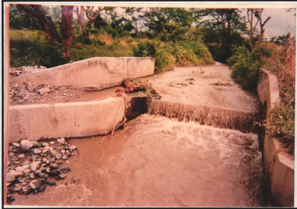
Fotografía 8.10. Canales de riego y suministro de agua en la zona. La gran mayoría se encuentran sin ningún tipo de recubrimiento; aunque éste posee estructura por ser el punto de desvío para la planta de tratamiento. (ej. Municipio de Pradera).
