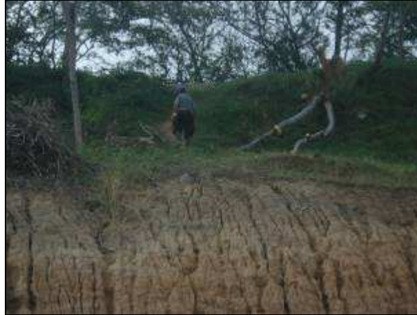
Figura 0.5. Erosión en el barrio Alto Bonito, cerca de la acequia Chambimbal.
