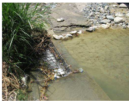
Foto 8.18. Bocatoma de la acequia El Chircal
