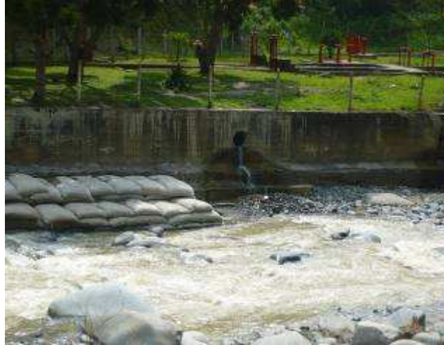
Figura 0.4. Margen izquierda rio Guadalupe, aguas abajo derivación Aguas de Buga
