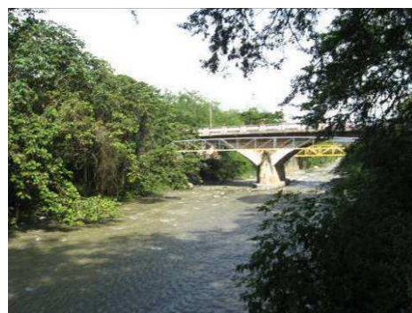
Foto 8.2. Puente del Ferrocarril, aguas arriba de la desembocadura en el río Cauca
