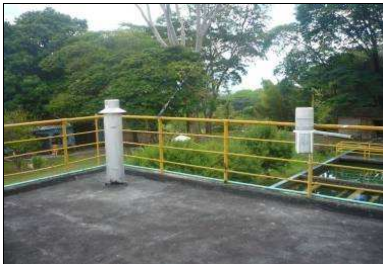
Foto 0.2. Estación Acueducto Buga
