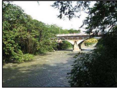
Foto 2. Puente del Ferrocarril (Carrera 20) en la zona urbana.
