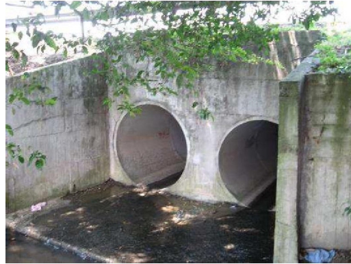
Foto 10. Quebrada La Honda en el cruce con la vía Panamericana.
