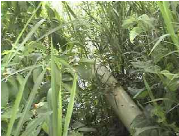
Foto 8. Desagüe de aguas lluvias a la madreveja
