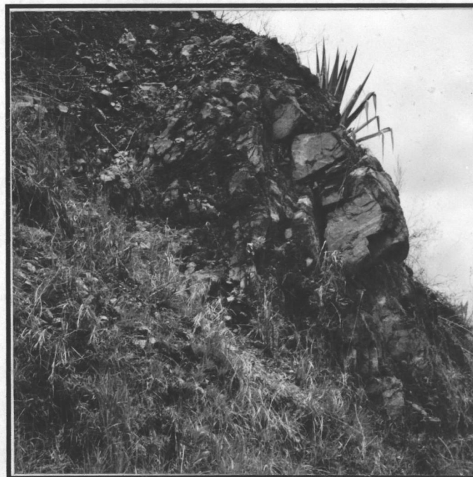
Fotografía 2.2.2. Néises anfibólicos moderadamente meteorizados, mostrando el patrón típico de diaclasamiento en bloques prismáticos paralelos a la ladera, originando deslizamientos de roca planares.
