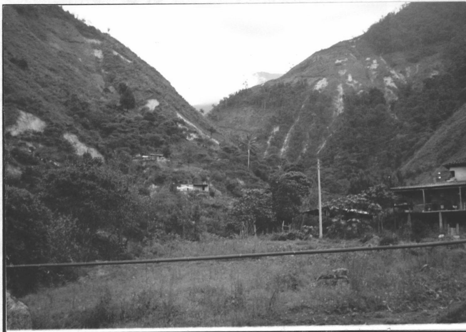
Fotografía 2.4.6. Desprendimientos generalizados en suelos bajo cultivos, bosques y praderas , aguas arriba de Granates en la cuenca de río Fraile.
