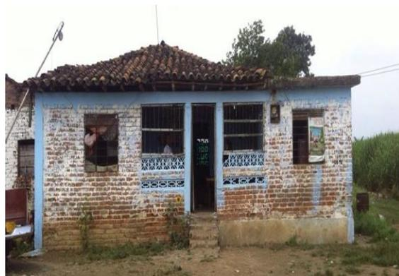
**Foto. A.3.5.** Edificación en ladrillo con techo en teja de barro
