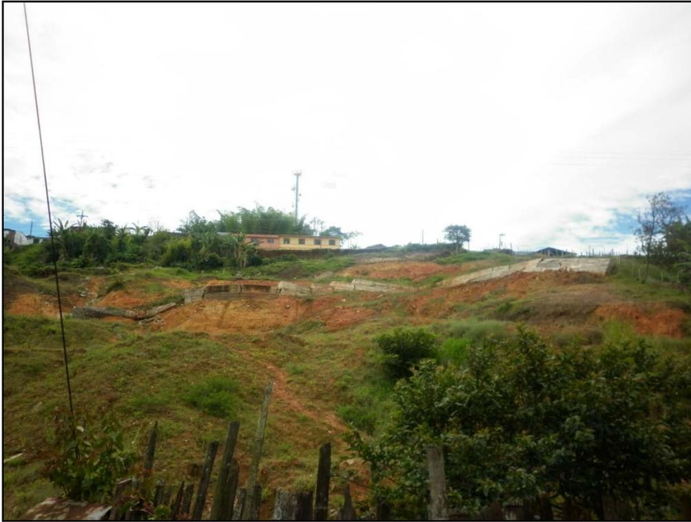
**Foto A2.** Efectos del deslizamiento del 22 de noviembre de 2010. Se observan las obras de estabilización que fallaron y las viviendas remanentes que fueron desalojadas.
