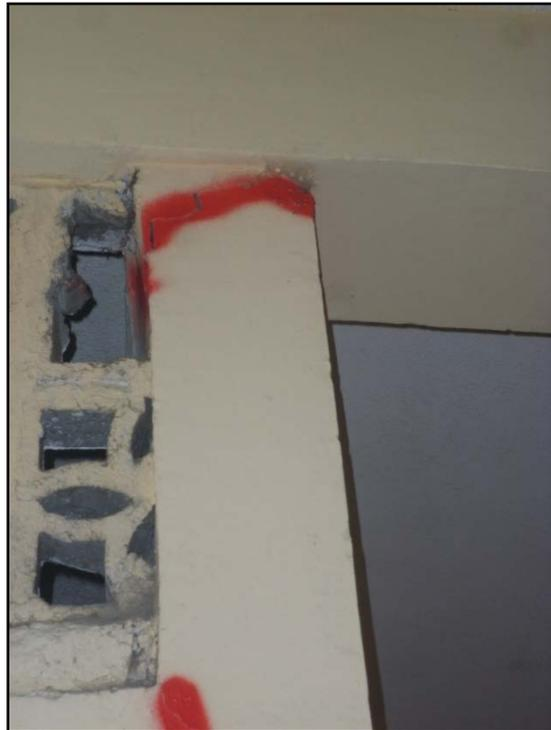
**Foto 10.5.** Fisura en columna por movimiento lateral
