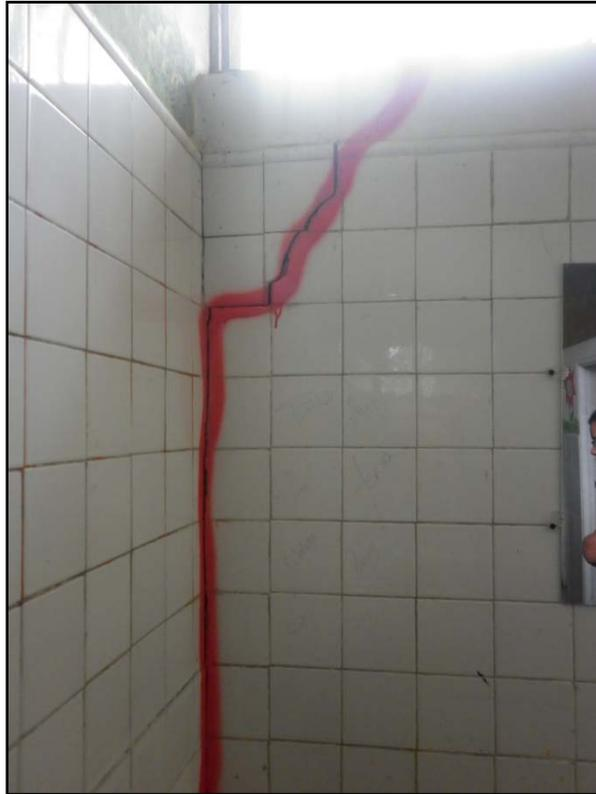
**Foto 10.4.** Grieta ( $e=0.5\text{cm}$ ) entre unión de muros
