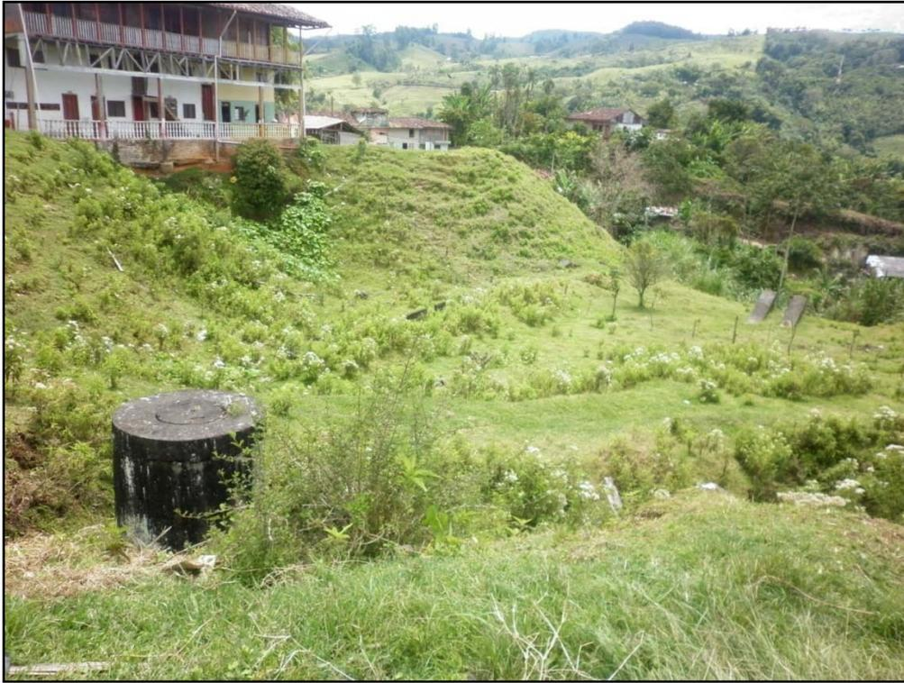
**Foto A1.** Lote ubicado sobre la carrera 45 con calle 49. Se observa cómo el terreno a cedido, según testimonios de los habitantes del sector, el lavadero estaba nivelado con la tapa de la cámara de descarga, también es apreciable el proceso de socavación en los cimientos de la vivienda continua.
