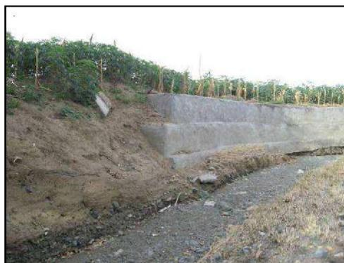
**Foto 8.4** Estructura de desviación del cauce de la quebrada La Unión.
