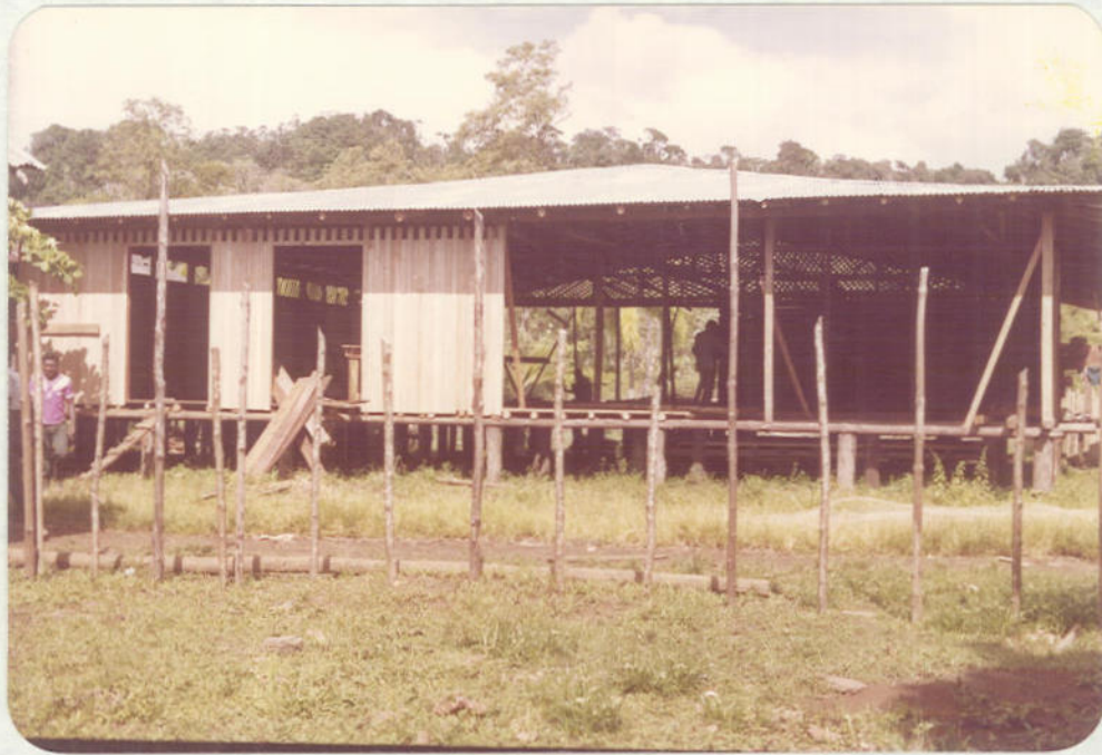
ASPECTOS DE LA CONSTRUCCION DE LA PLANTA DEL MOLINO - SALAHONDA-PIZARRO - OCTUBRE/83.
