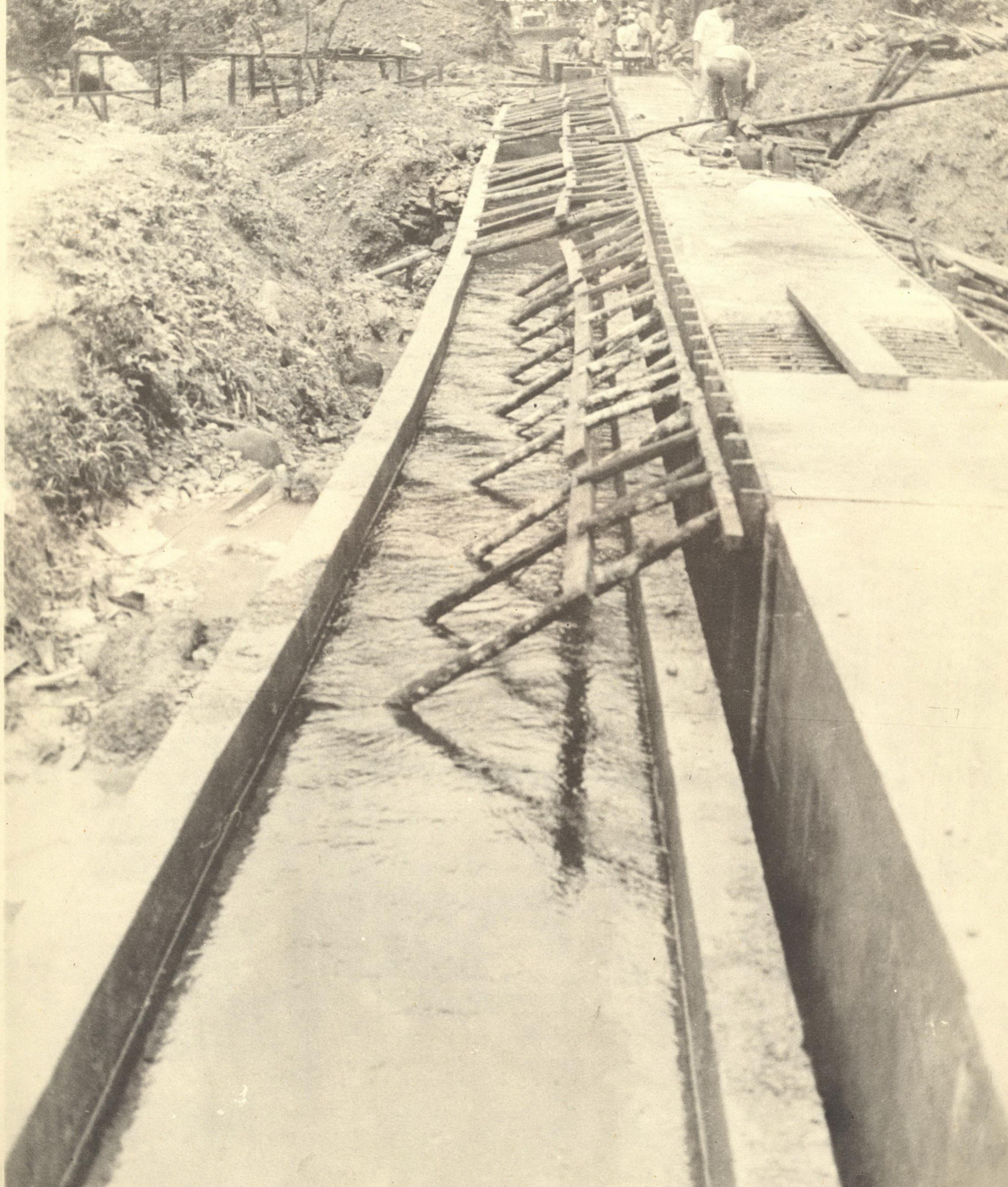
SUBPROGRAMA DE ACUEDUCTO FUNDICION-TRAMO NUEVO CANAL DE CONDUCCION PARALELO A CANAL EXISTENTE.
